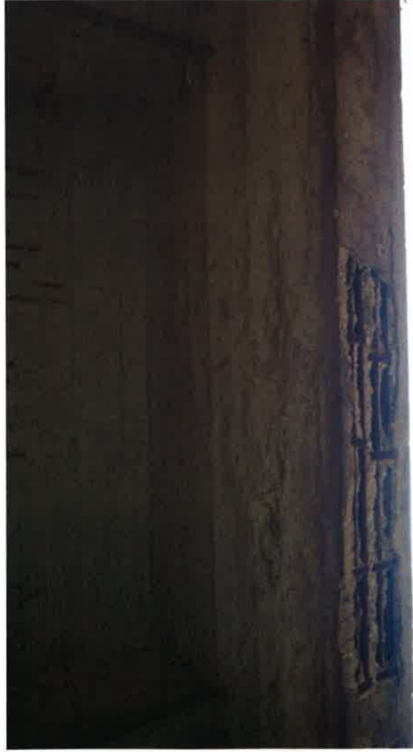
09 detail podhledu trámu v pravém poli.JPG
